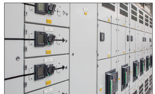
LV Switchgear
